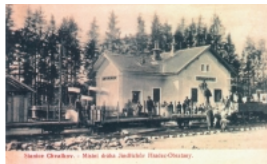
Stavba Obrataně - Místní dráha Jindřichov Hradce-Obrataně.
